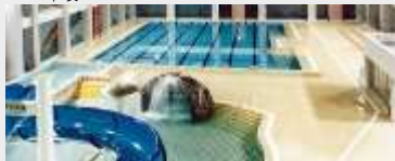
大崎市(古川市)プール等 スポーツ施設新築工事(JV)
