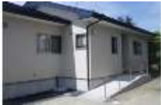
個人様邸宅 新築工事（設計・施工）
