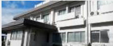
高橋医院 外壁改修工事
