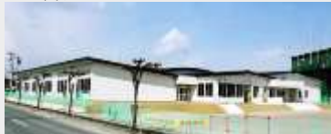
美里町立南郷幼稚園・保育所 建築工事
