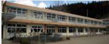
大崎市立上野目小学校 災害復旧工事
