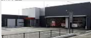
古川消防署田尻分署庁舎等 建設工事(建築)
