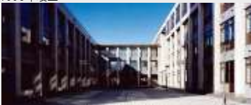
宮城県古川工業高等学校 総合実習棟改築工事（JV）
