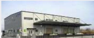
株式会社大昇物流 石田地区倉庫新築工事 (設計・施工)
