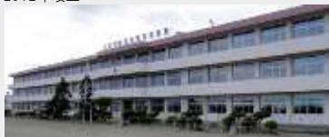
大崎市立古川第三小学校校舎 耐震補強及び大規模改修工事
