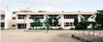
大崎市立川渡小学校 校舎耐震補強及び大規模改修工事
