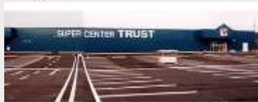
Su.トラスト岩出山店 新築工事 (設計・施工)
