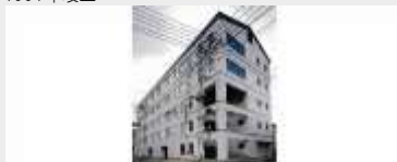
大崎市(古川市) 市役所東庁舎新築工事
