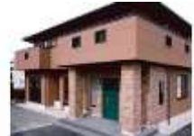
個人様邸宅 新築工事（設計・施工）
