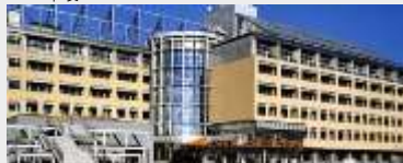
宮城県古川合同庁舎 新築工事(JV)
