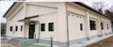
大崎市立鹿島台中学校 武道場改築工事
