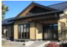
個人様邸宅 新築工事（設計・施工）
