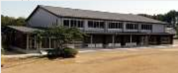
大崎市立大貫小学校 屋内運動場改築工事
