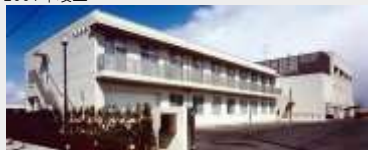
宮城県総合福祉センター新築工事
