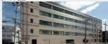
大崎市役所東庁舎 改修工事
