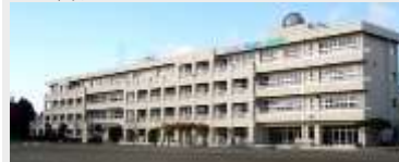
大崎市立鹿島台中学校 校舎耐震補強及び大規模改修工事
