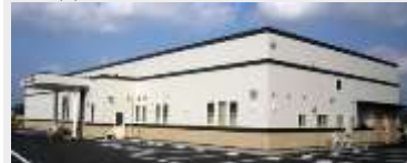
葬祭会館 葵 新築工事
