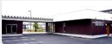
有限会社佐々木薬局 店舗新築工事 (設計・施工)
