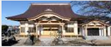
雲谷山龍洞院 本堂等新築工事
