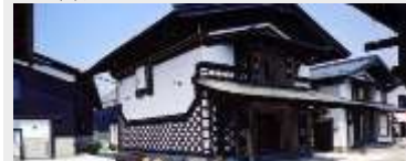
大崎市緒絶川周辺商業施設 醸室(かむろ)整備建設工事 (JV)
