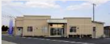
JA古川 通夜会館・斎場建設工事
