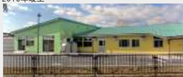
松山幼保一元化施設 建設工事（建築）
