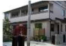
個人様邸宅 新築工事（設計・施工）
