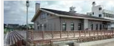
大崎市上古川配水場 建設工事
