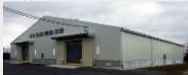
クミアイ化学工業株式会社 小牛田工場第7倉庫新築工事 (JV)
