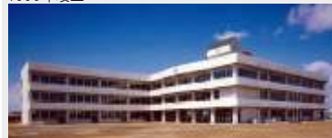
大崎市立古川第四小学校 校舎及び給食室新築工事
