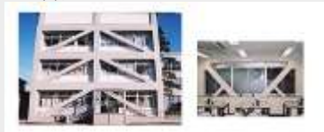
大崎市役所本庁舎 耐震補強工事
