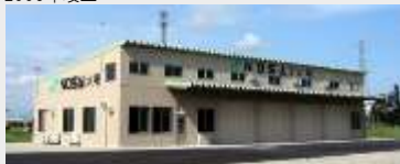
大崎農業共済組合 実測センター新築工事 (設計・施工)
