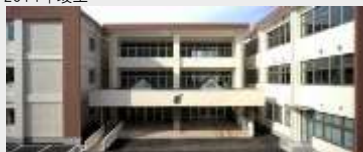
学校法人古川学園 高校校舎新築工事
