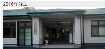
大崎市古川障害者地域活動支援センター あしたの広場新築工事
