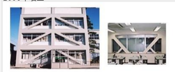
大崎市役所本庁舎 耐震補強工事
