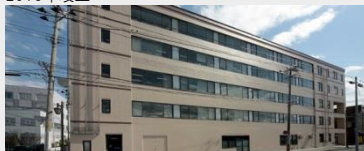
大崎市役所東庁舎 改修工事
