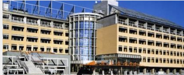
宮城県古川合同庁舎 新築工事（JV）
