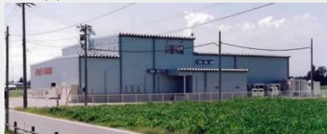
株式会社フルカワミート 工場新築工事
