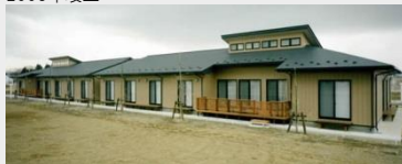
社会福祉法人南郷福祉会 いなほの里グループホーム建設工事
