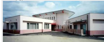
社会福祉法人南郷福祉会 いなほの里ケアハウス建設工事
