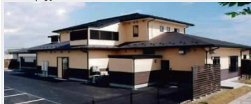
セカンドハウスほなみ 新築工事（設計・施工）
