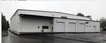
ヤマセ電気株式会社 成形・金型工場棟新築及び外構その他工事
