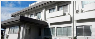
高橋医院 外壁改修工事
