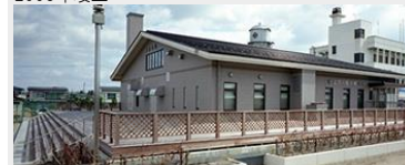
大崎市長古川配水場 建設工事
