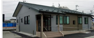
社会福祉法人大崎誠心会精神障害者通所 小規模作業所ひだまり新築工事
