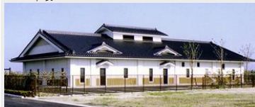
大崎市飯川地区 農集排1号処理場建設工事
