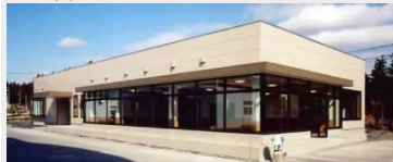
北日本工業株式会社 福利厚生棟新築工事
