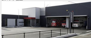
古川消防署田尻分署庁舎等 建設工事（建築）
