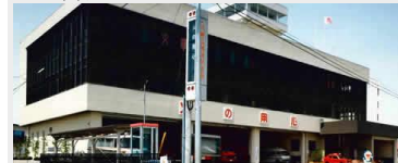
大崎地域広域行政事務組合 消防庁舎新築工事
