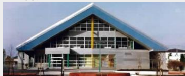
南郷町健康づくりのスイミングセンター 建設工事（建築工事）
