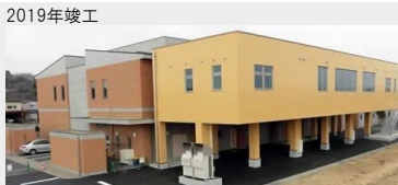
大脳市民病院岩山分院 リハビリテーション施設増築工事（建築）
