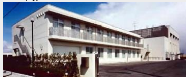
宮城県総合福祉センター新築工事
